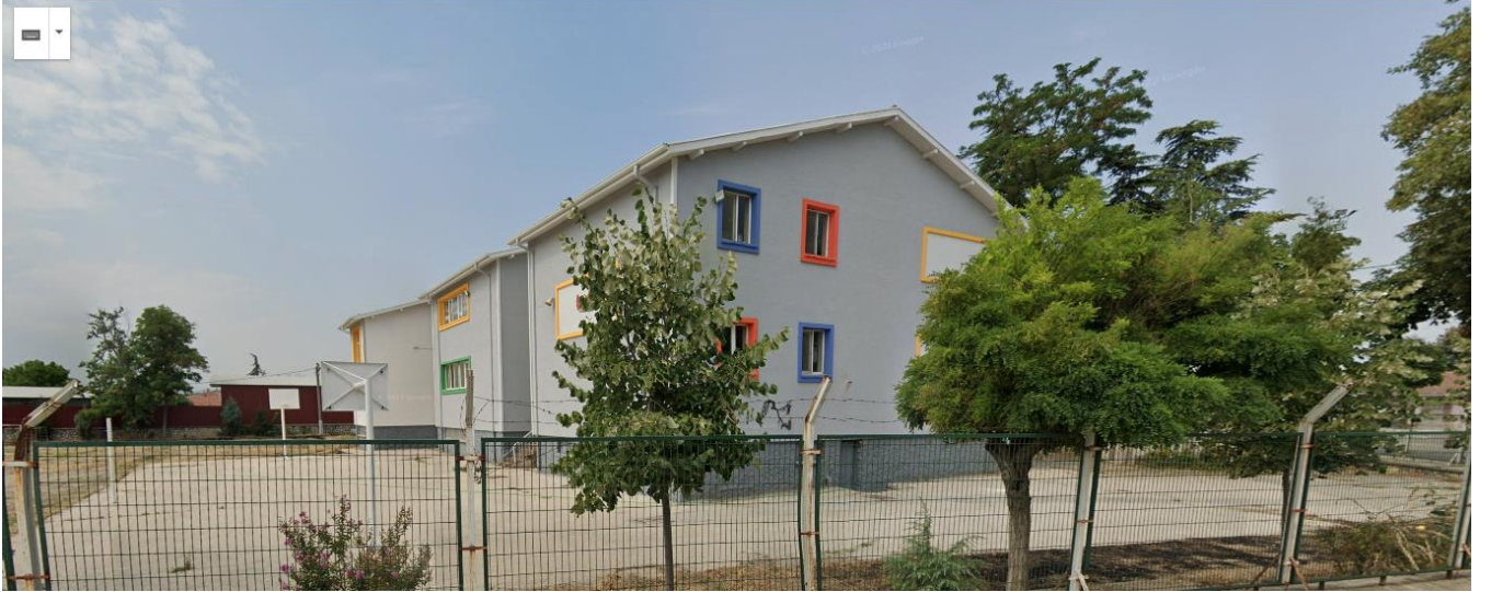
Görsel -3 Okulumuz yan cephe görünümüne ait fotoğraf
